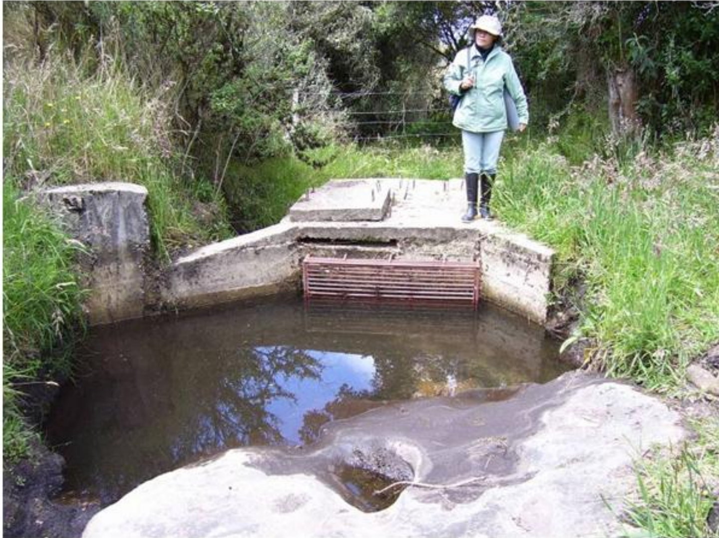
captación del acueducto ASOCHORRERAS sobre el cauce del zanjón El Vinc
